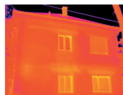
Wärmebild ohne testo ScaleAssist
