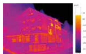
Wärmebild mit testo ScaleAssist
