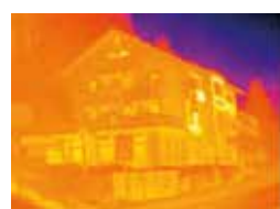
Wärmebild ohne testo ScaleAssist
